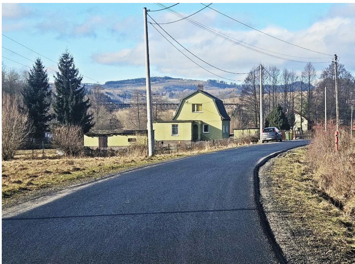
Droga Przygórze – Nowa Ruda (Zatorze)
