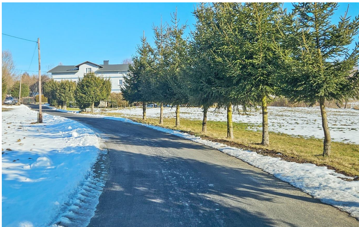
Droga gminna w Bartnicy
