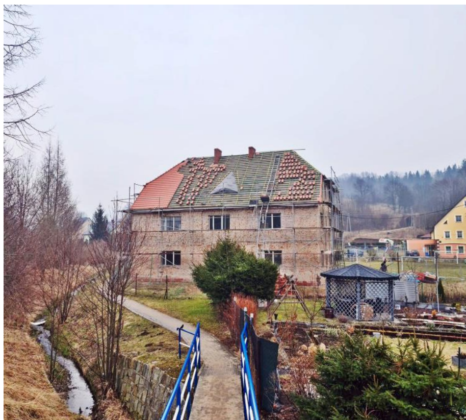
Budynek w Dzikowcu 95 w trakcie robót budowlanych
